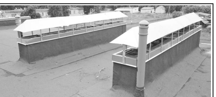
ствующие вентиляционные каналы отремонтированы и закрыты металлическими элементами от непогоды. Положена мягкая кровля.
