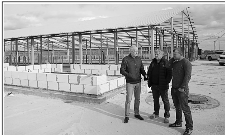
Полным ходом идет строительство нового современного коровника. На фото председатель СХПК «Штурм» С. И. Дзюбан, заместитель главы администрации района по сельскому хозяйству А. В. Рыбкин, бригадир СХПК «Штурм» С. В. Ильинец
