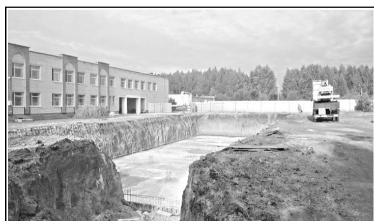
На сегодняшний день вырыт котлован под чашу бассейна, вывезена лишняя земля. Укреплено арматурой и залито бетоном основание чаши. После уплотнения бетона работы продолжатся.
